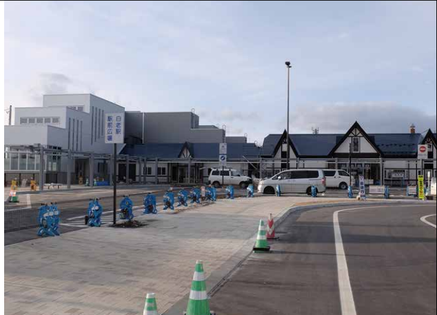
▲エスカレーター付きの高架橋を新設したJR白老駅
